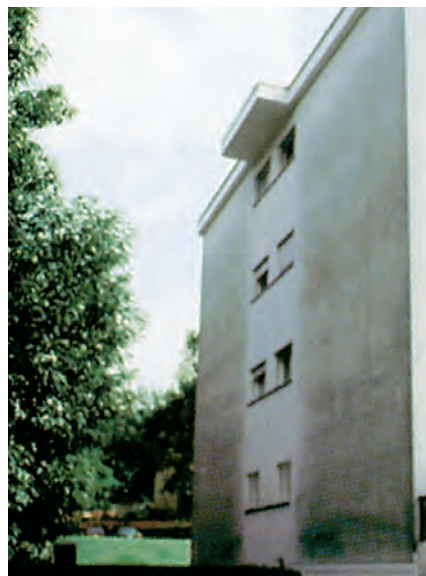
(Fig. 14) Une avancée de toit en saillie protège contre l'humidité
