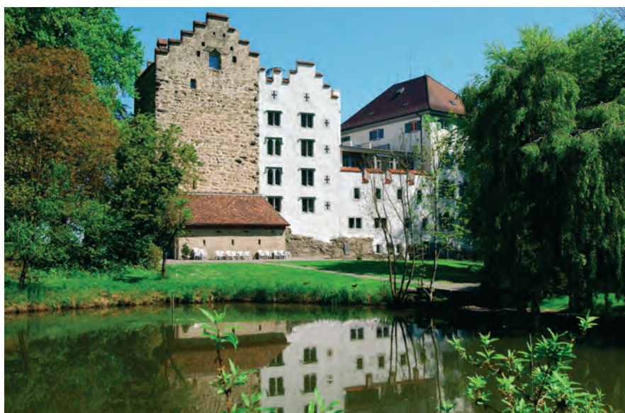
Château du Warthensee, Rorschacherberg (SG) rénové en 1996 avec CALSILIT AS-PROTECT peinture silicate pour façades.
