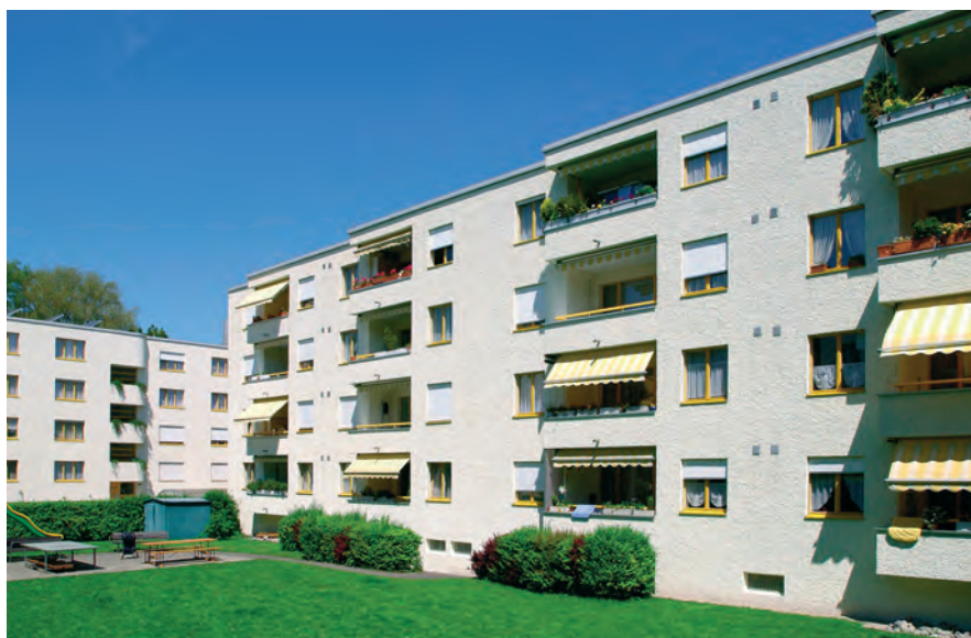
Immeuble locatif (TG) rénové en 1998 avec CALSILIT AS-PROTECT peinture silicate pour façades et NOVALITH AS-PROTECT peinture silicate APS pour façades.
